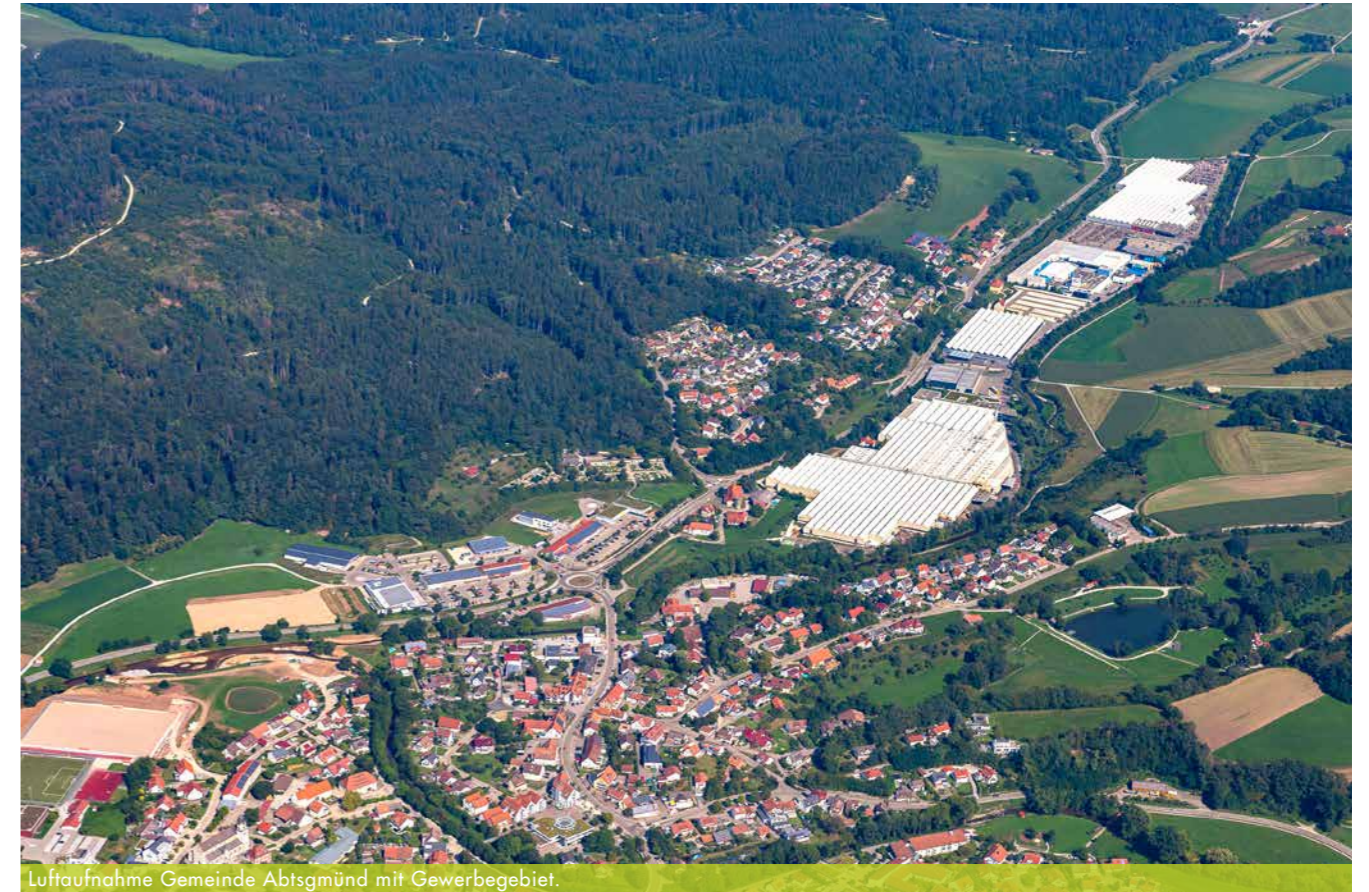
Luftaufnahme Gemeinde Abtsgmünd mit Gewerbegebiet.
